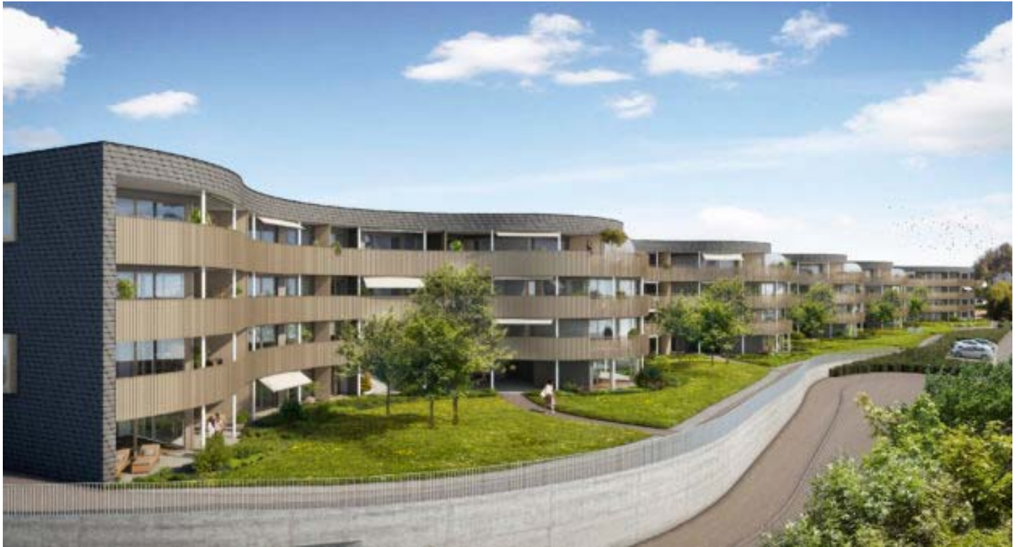
Die Überbauung welle-lenzburg.ch soll 2019 fertig gestellt werden (Quelle: Fortimo Group AG)
