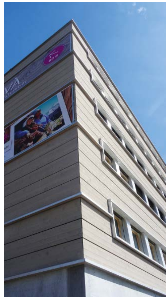
Das rund 18 Meter hohe Personalhaus weist innen und aussen brennbare Oberflächen auf. Bild: Graubünden Holz
