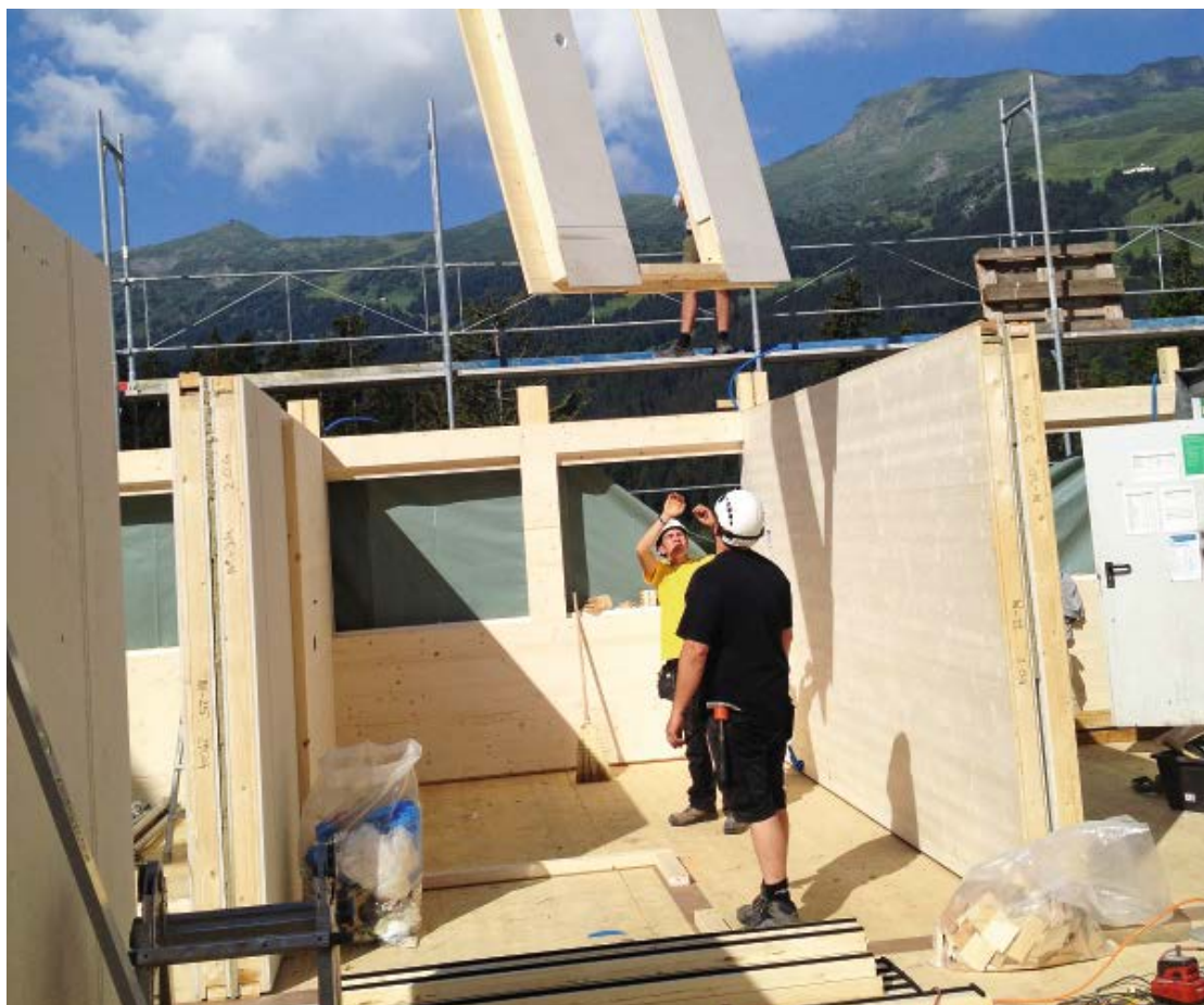
Die Elemente wurden im Werk mit den fertigen Oberflächen hergestellt und anschliessend auf der Baustelle aufgerichtet.
