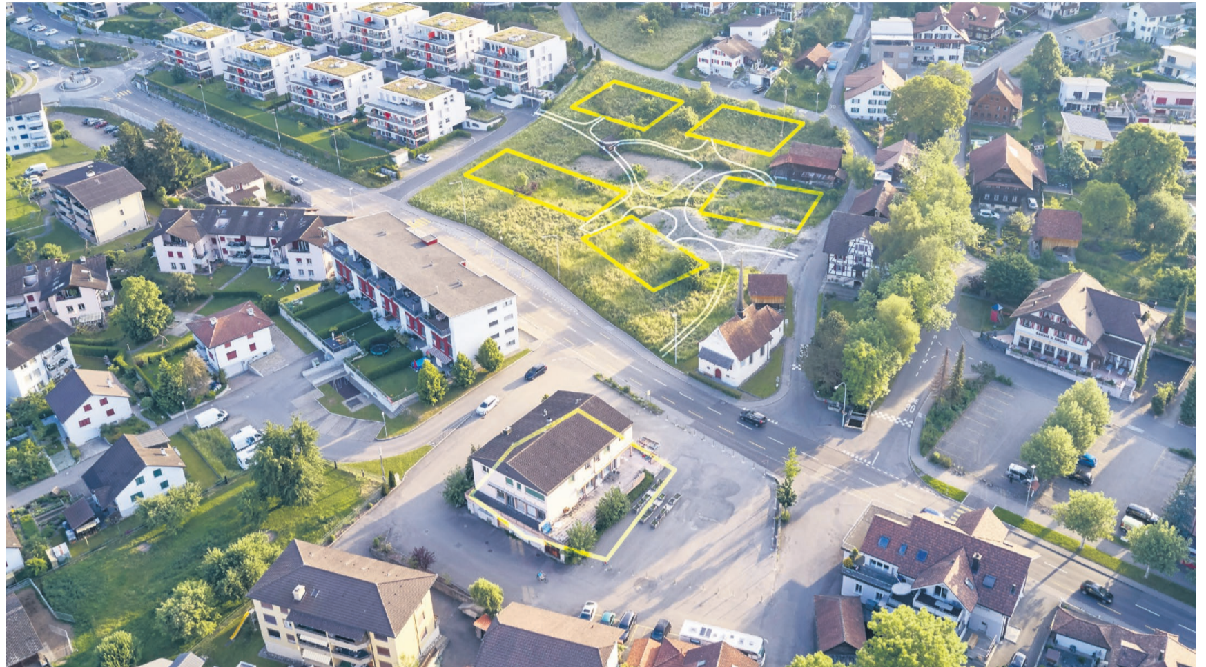
Das Sternenhaus wird auf dem Grundstück des heutigen Gasthauses Sternen entstehen. Auf der gegenüberliegenden Strassenseite, auf dem Areal Heugärten, sollen fünf Blöcke gebaut werden. FOTO ZVG
