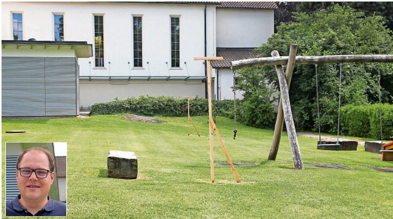
Die Bewilligung für den neuen Spielplatz bei der evangelischen Kirche in Münchwilen liegt vor. Ein Plan besteht bereits: «Dort, wo jetzt noch Visiere stehen, wird das Terrain aufgeschüttet», sagt Markus Gehret (kl. Bild). Somit entstehen zwei Spielhügel. jac
