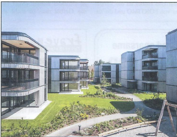
Um die grosszügige Gartenanlage gruppieren sich die aus Holz heimelig, aber sehr modern gestalteten Häuser.
