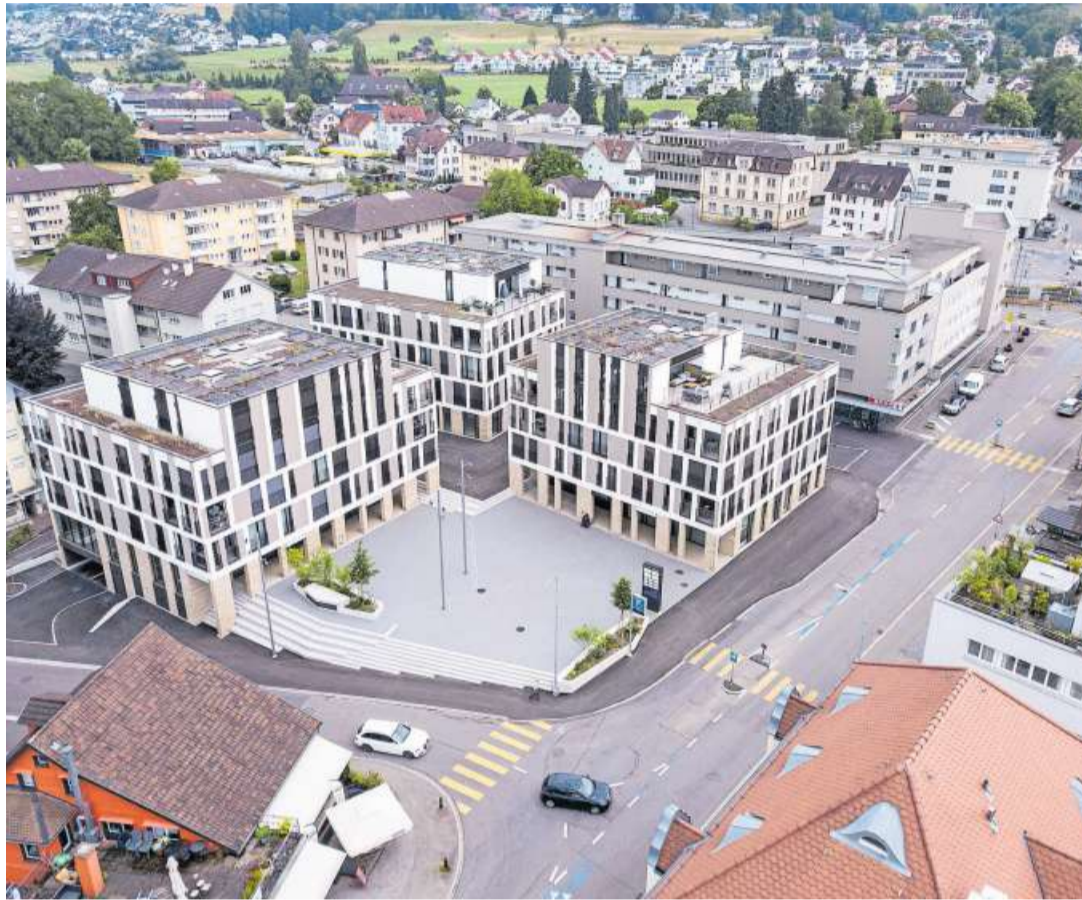
Der Weg zum neuen Goldacher Zentrum war lang. Über mehrere Jahre war das Bauvorhaben blockiert – im Oktober 2020 erfolgte schliesslich der Spatenstich. Bild: Tino Dietsche
